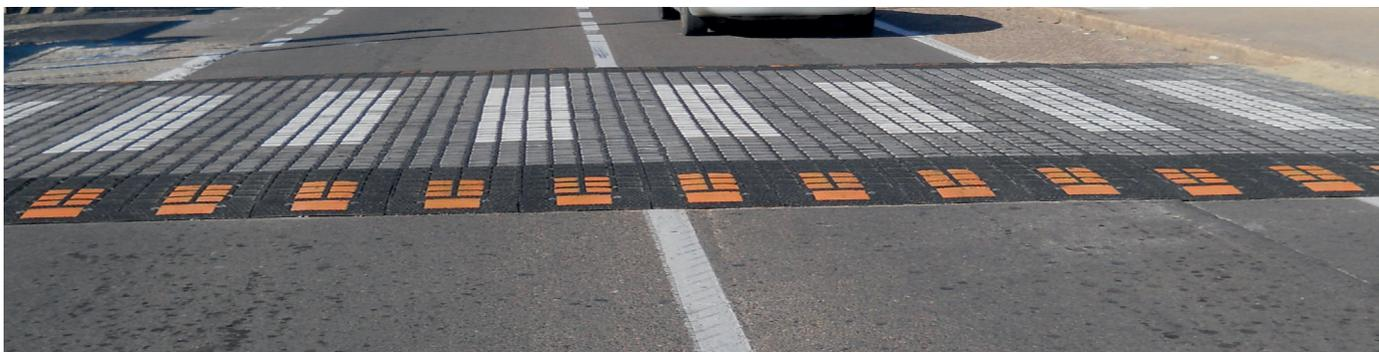
all'usura. Per incrementare la visibilità notturna del prodotto sulle rampe lato di ingresso autoveicoli sono applicati inserti in elastoplastico rifrangente.
